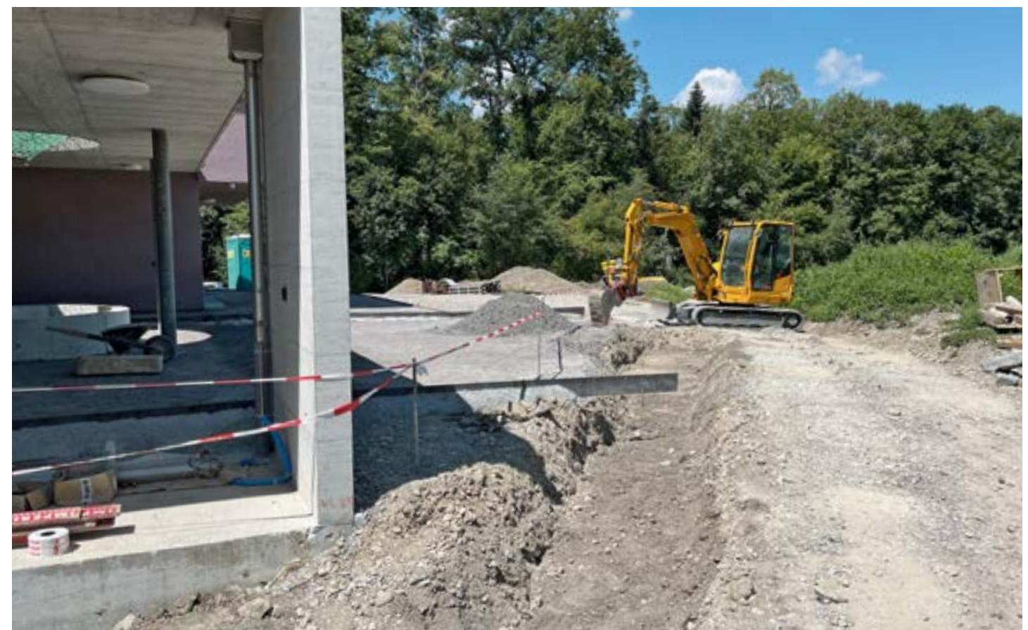
13: Umgebungsarbeiten beim Haupteingang (10.07.2022)
