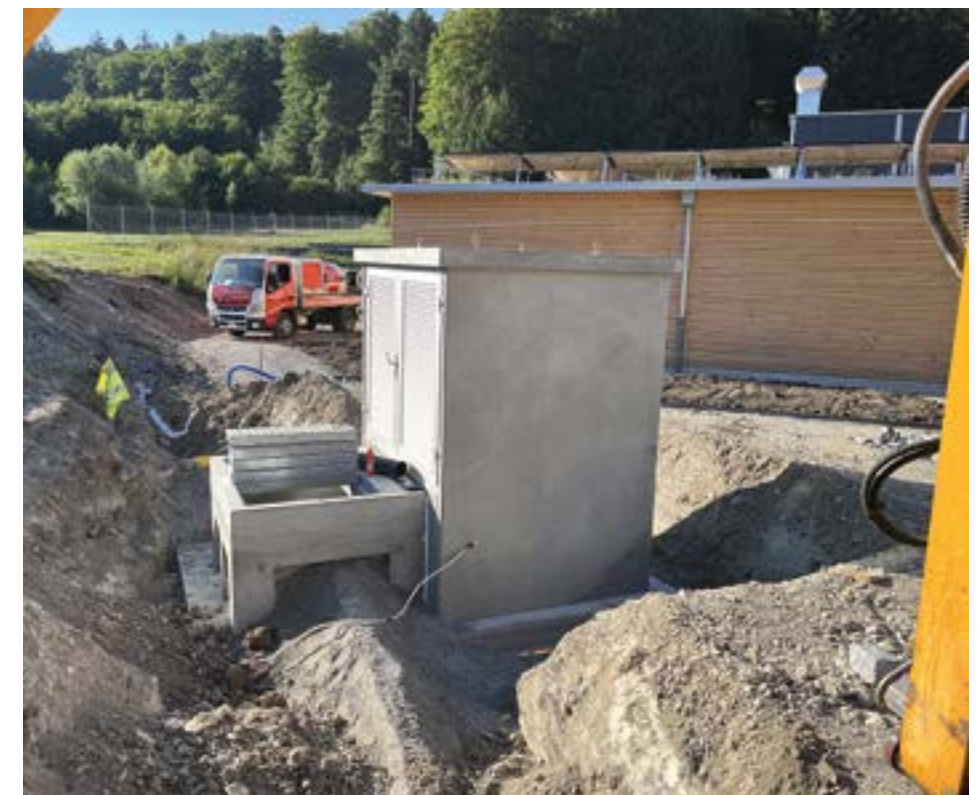
12: Einbau Trafostation (19.07.2022)
