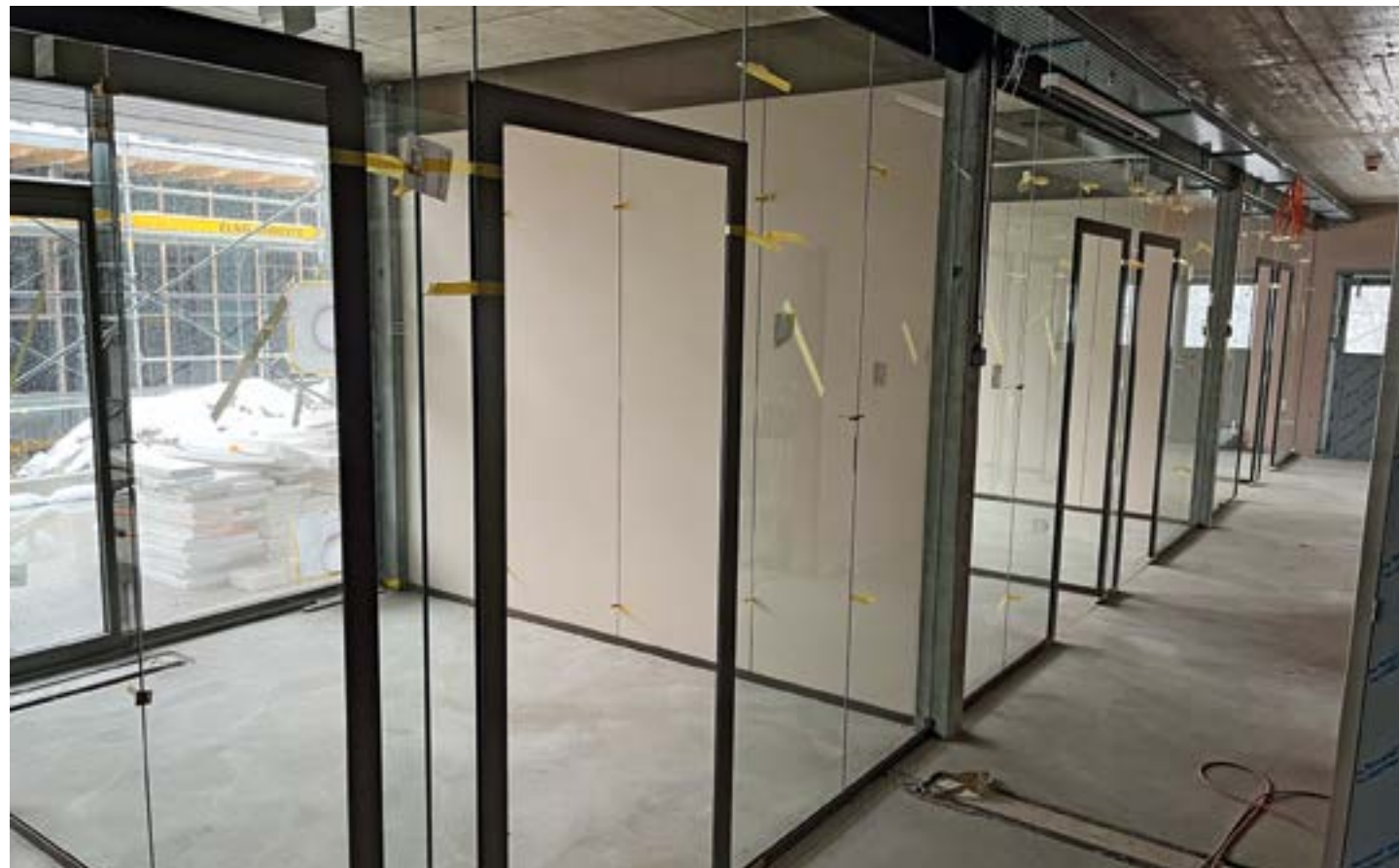
4: Einbau Trennwände Katzenhaus 1 (21.03.2022)
