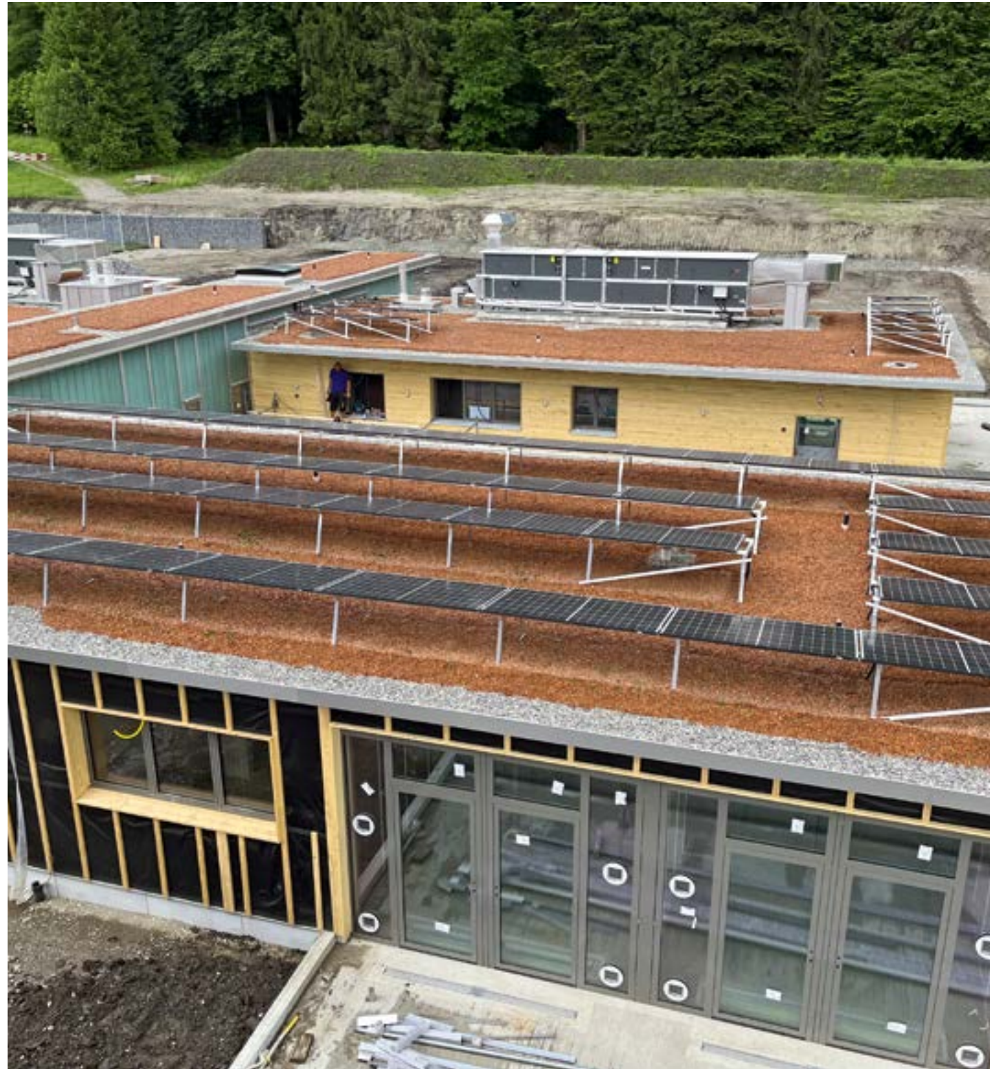
7: Aufstellen der Sonnenkollektoren (24.05.2022)
